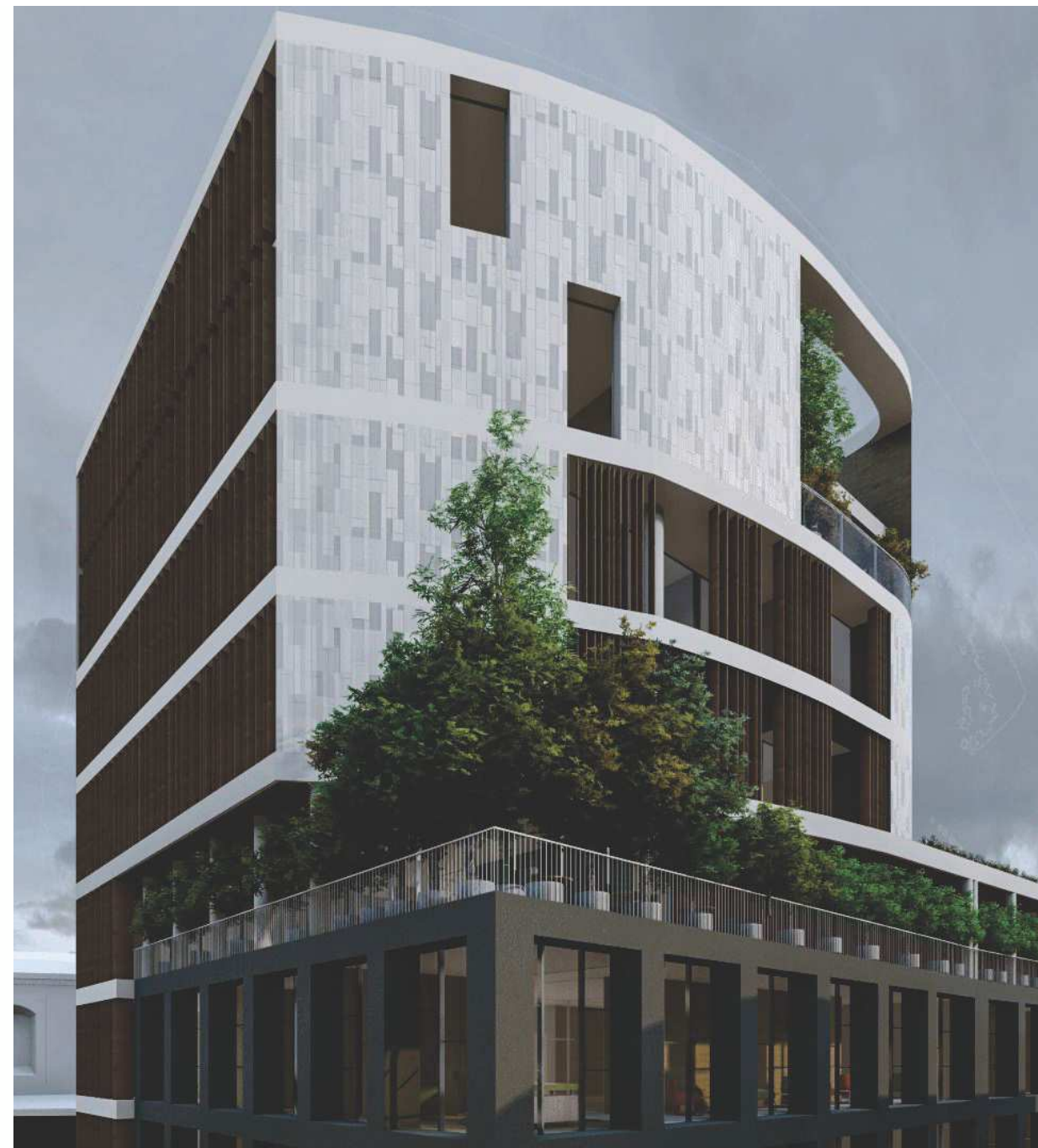
vista esterna della facciata sud/ovest
